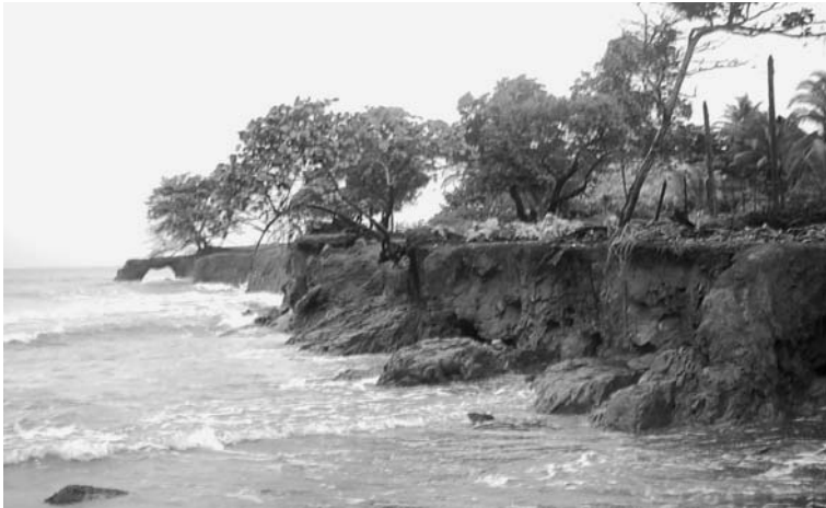
Figuras 3 a. y b. Obsérvese cómo el oleaje embate de forma directa sobre los acantilados, generando rasgos erosivos como arcos marinos y acanaladuras. También se observan restos de árboles sobre el tope del acantilado, indicio del retroceso de la terraza.
