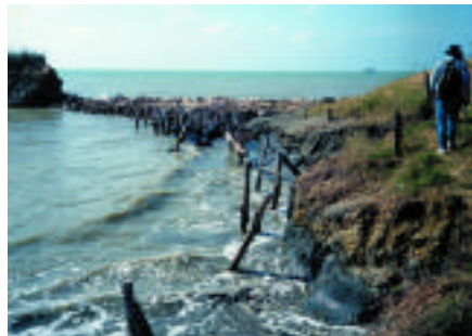
Figura 11. Vista del espolón 13A, que une la terraza de Arboletes con un remanente rocoso de erosión. Al impedir el tránsito litoral, este espolón genera una erosión intensa, hacia el sur, con velocidad de hasta 6 a 7 metros/año. En el horizonte, a la derecha, se divisa Isla Rey, extremo oeste de la desaparecida península de Punta Rey. La distancia actual entre la isla y la línea de costa es de 1.6 km.
